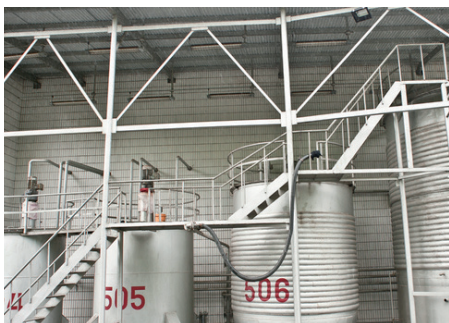
燃料タンク室
