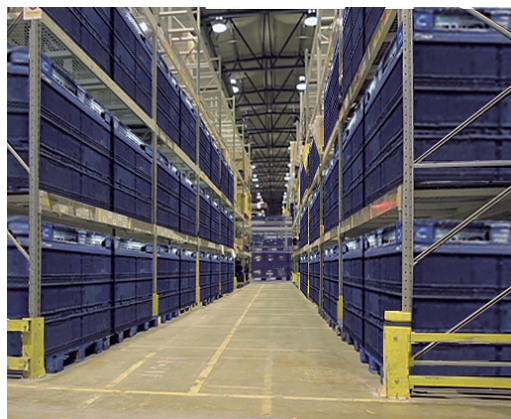
(用途事例) 防爆区画のある階高 8m 以上の危険物倉庫
